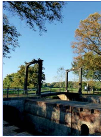
> Seite 134 Relikt vom Eiderkanal: Schleuse bei Kluvensiek
