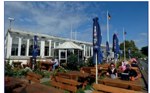
Der Kern der Schiffsbegrüßungsanlage ist in einem kleinen Glas-Pavillon untergebracht.
