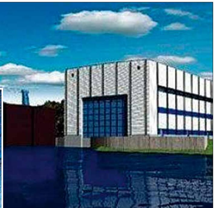
Künftig sollen Reparaturen von beschädigten Schleusentoren und auch routinemäßige Wartungen und Inspektionen in einem eigenem Trockendock der Kanalverwaltung erledigt werden. Es soll 80 m lang, 26 m breit und 22 m hoch werden.
