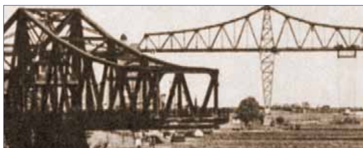
> Seiten 30-31 1907 bis 1914: Der erste Kanalausbau
