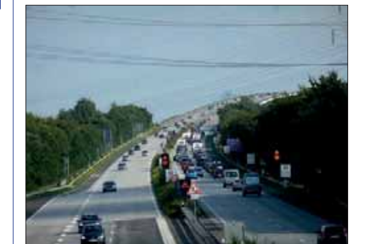
Der Rendsburger Autotunnel als Ersatz für die Rader Autobahnbrücke? Er war nur einspurig befahrbar und verstärkte das Verkehrs-Chaos in der gesamten Region Mittelholstein.
